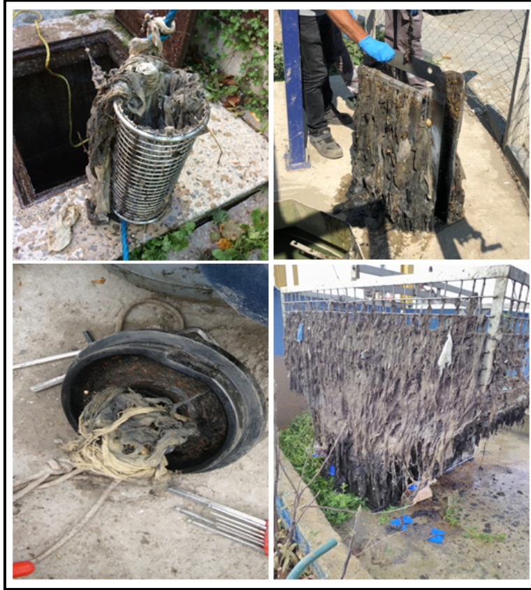
Şekil 4.2 Terfi Merkezlerinden Çıkan Islak Mendiller
