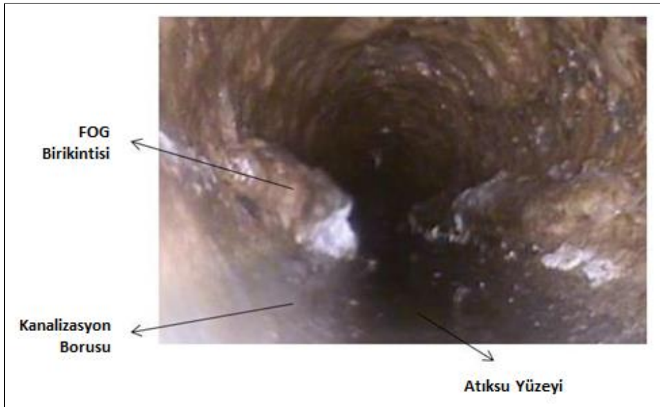
Şekil 2-2 Kanalizasyon Sisteminde Blokajlanma
