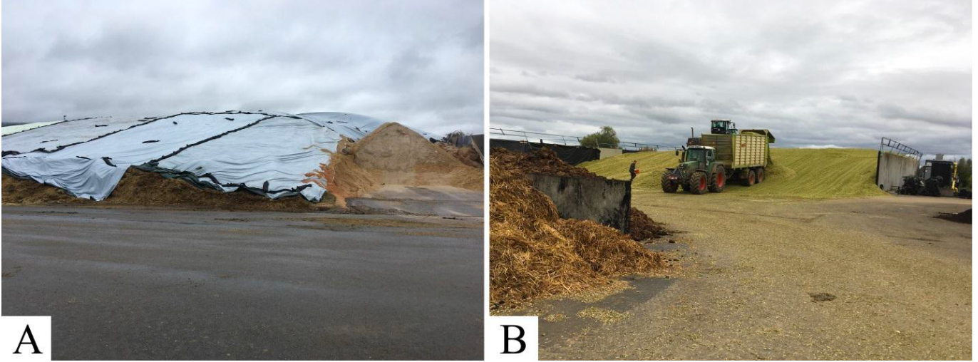
Şekil 3-1. (A) Biyogaz Tesisi Hammadde Yığını Üzeri Kapalı ve (B) Traktör Tarafından Beton Bunker Silosunda Preslenmiş Biyokütle Hammaddesi
